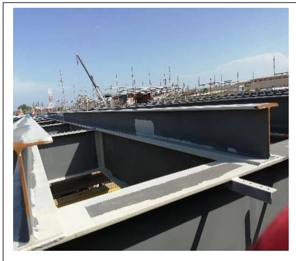
Sandblast sspc-sp5 y aplicación de recubrimiento en plataformas marinas de Grupo R y Dragados
